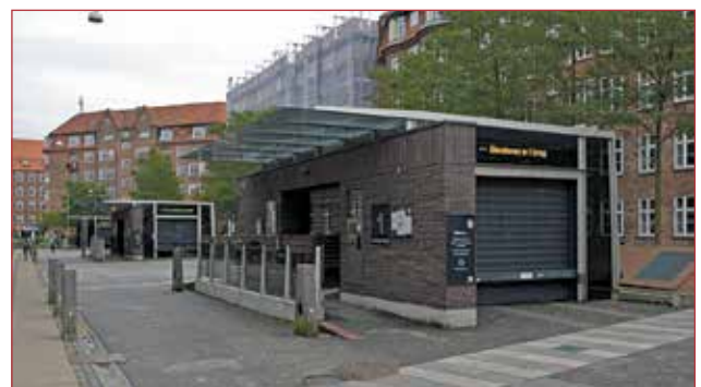
Det underjordiske parkeringsanlæg ved Under Elmene består af tre elevatorer. Det er det eneste, der er synligt over jorden.
